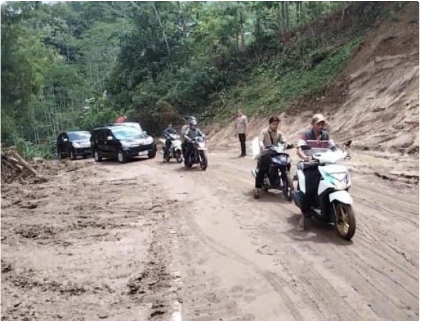
Pembukaan Jalan Selajambe-Cipasung Paska Longsong Yang Menutup Jalan
